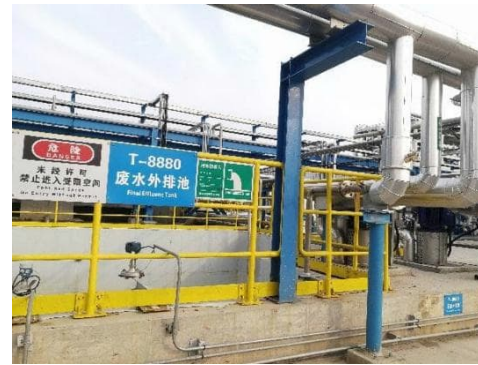
污水总排口 DW001 标志牌
