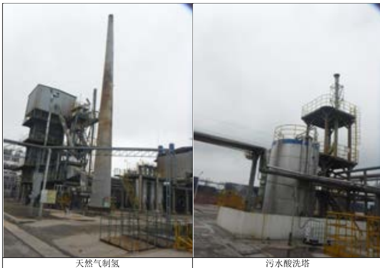
图 3.1-4 厂区建设现状
